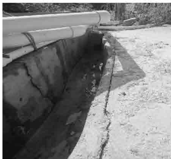
区内已建成排水沟现状 (2018.05)
