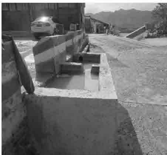
区内已建成沉沙池现状 (2018.04)
