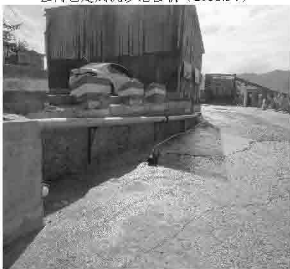
区内已建成排水沟现状 (2018.05)
