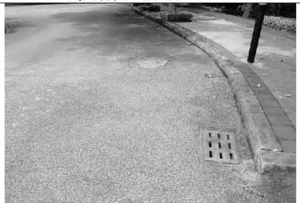
已建成道路排水工程现状 (2018.7)
