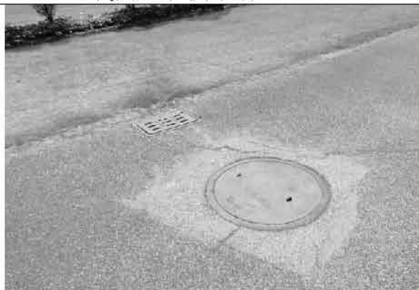
已建成道路排水工程现状 (2018.7)
