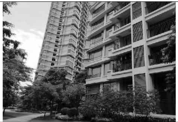
已建成主体建筑现状 (2018.7)
