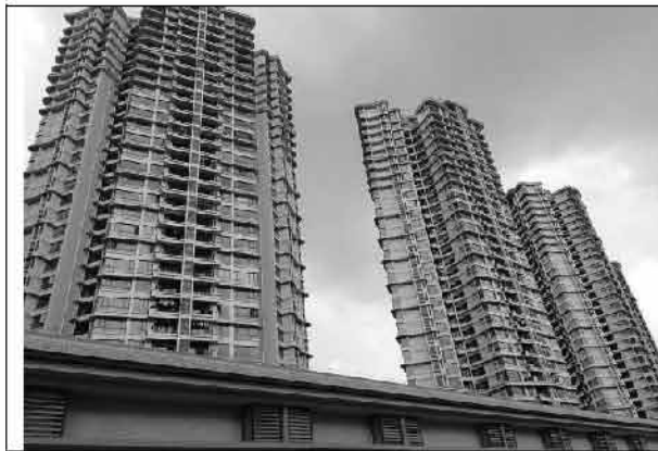
已建成主体建筑现状 (2018.7)
