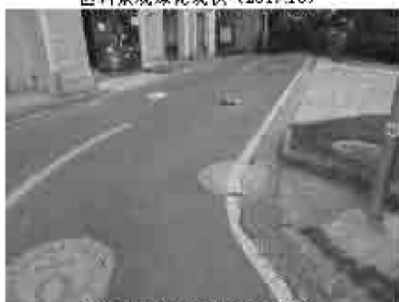
区内排水管网现状 (2017.10)
