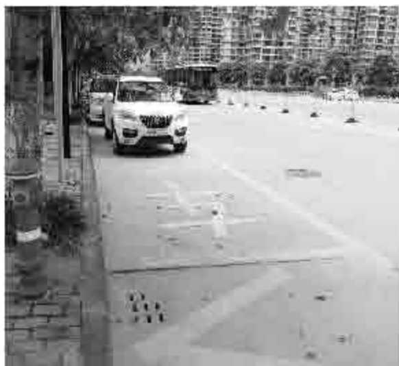
已建成硬化道路现状 (2018.7)
