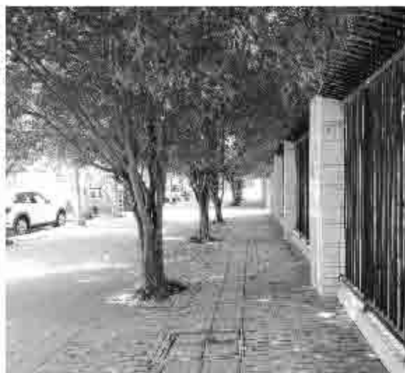
已建成硬化道路现状 (2018.7)
