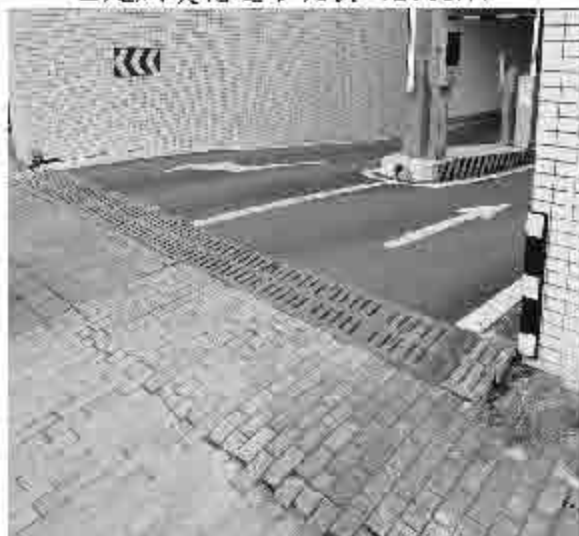
已建成截洪沟现状 (2018.7)
