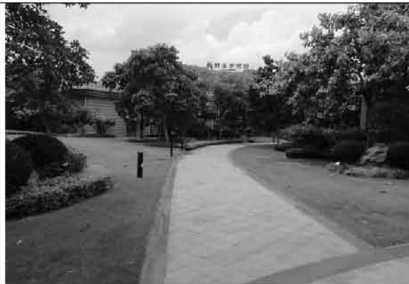
已建成人行道路现状 (2018.7)
