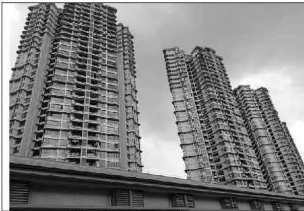
已建成主体建筑现状 (2018.7)
