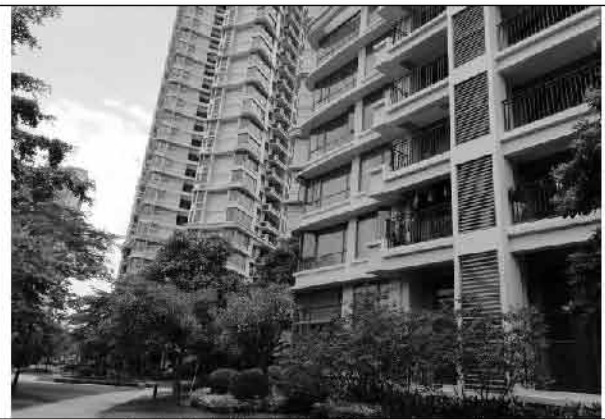
已建成主体建筑现状 (2018.7)
