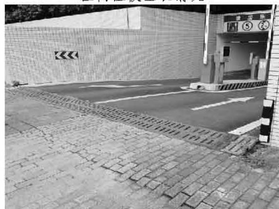
排水工程措施现状
