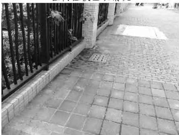
排水工程措施现状
