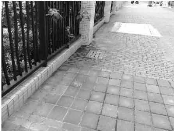
已建成雨水管网现状 (2018.7)
