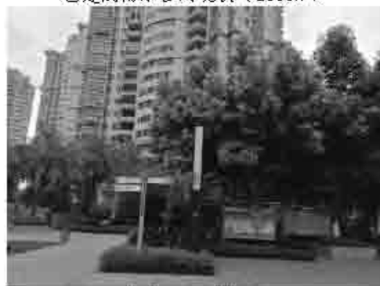
已建成主体建筑现状 (2018.7)
