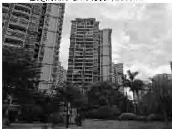
已建成主体建筑现状 (2018.7)
