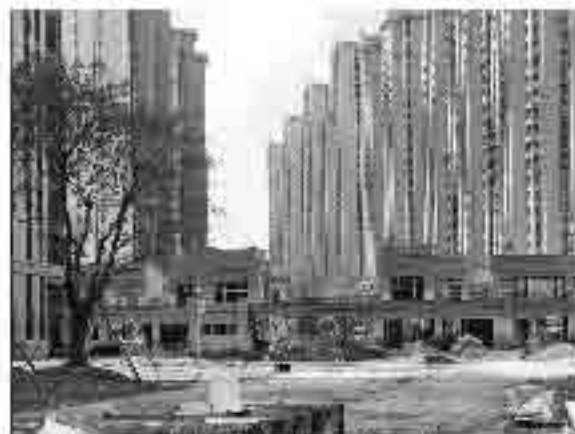
已完工的建筑主体结构现状 (2018.9)
