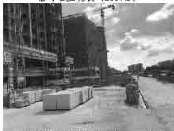
区内主体建筑物现状 (2017.6)
