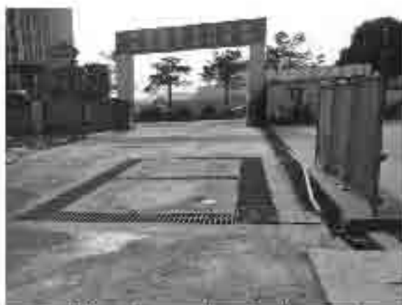
工程施工出入口洗车槽 (2016.9)
