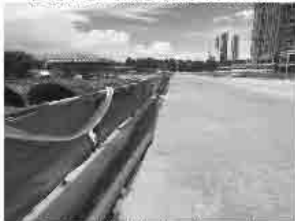
区内临时排水沟现状 (2017.6)
