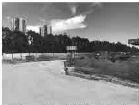
区内已硬化施工道路现状 (2017.9)
