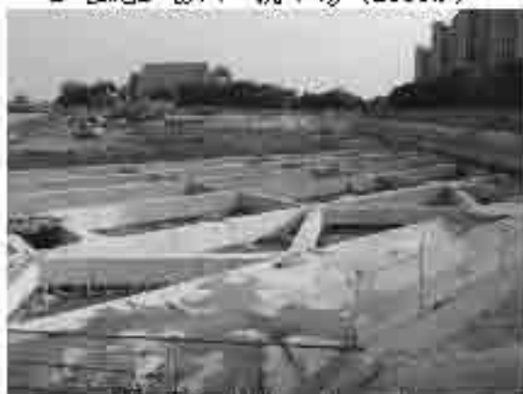
基坑连续墙现状 (2016.9)
