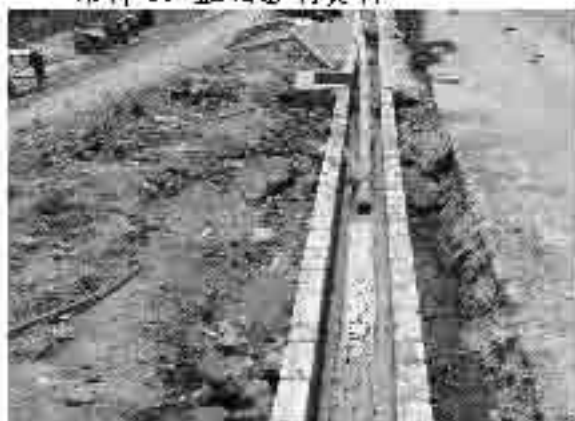
基坑截排水沟 (2016.6)
