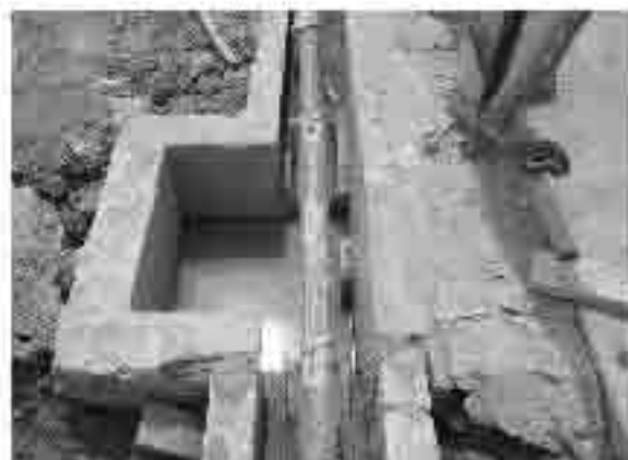
基坑周边集水井 (2016.6)
