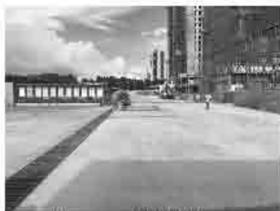
西北侧施工出入口处洗车槽现状 (2017.6)
