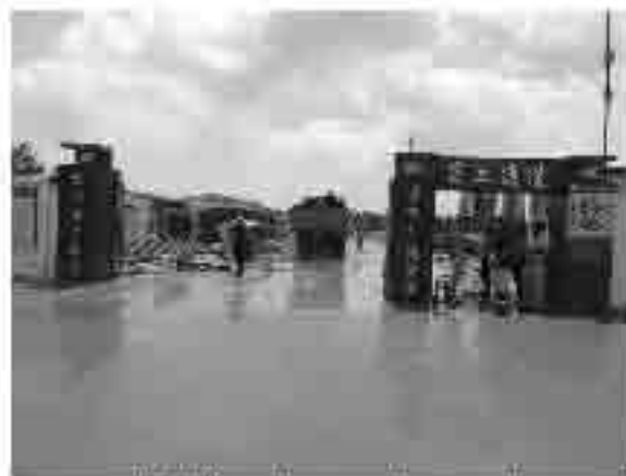
西北侧施工出入口 (2016.6)
