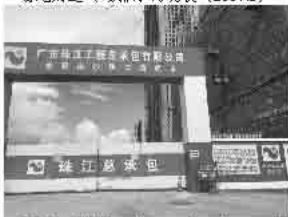
项目区西北侧施工出入口现状 (2017.6)
