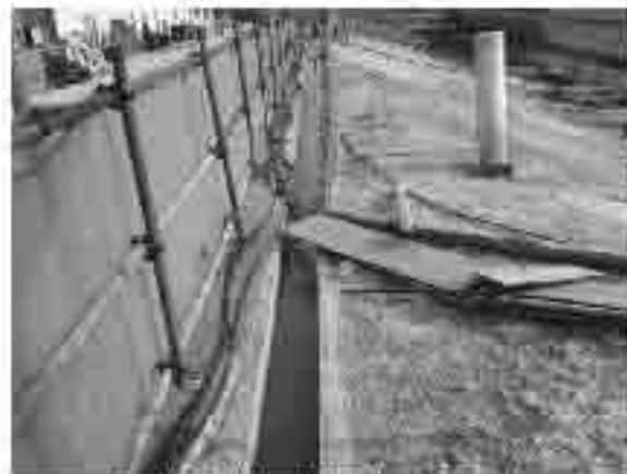
基坑周边排水沟 (2016.12)
