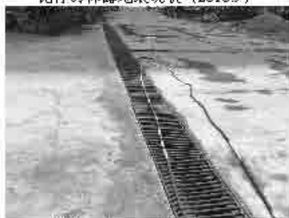
西侧施工出入口现状 (2018.9)
