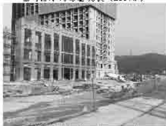
主体建筑物现状 (2017.12)
