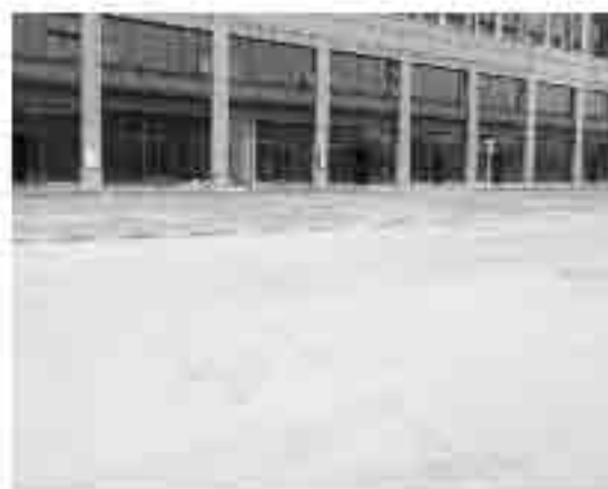
区内已建成硬化地面现状 (2018.12)
