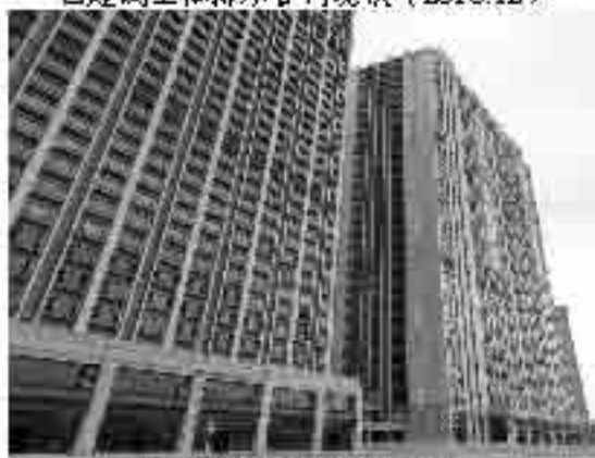
主体建筑现状 (2018.12)
