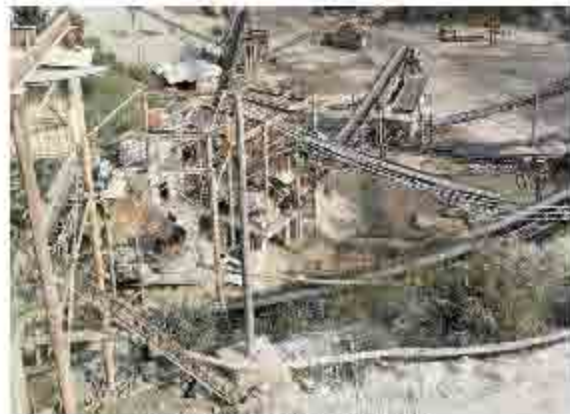
矿区工业场地 (2016.04)
