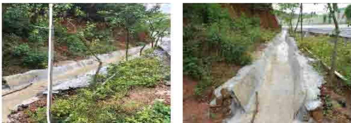
浆砌石排水沟
