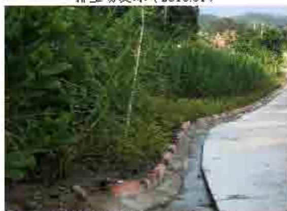
矿区道路旁排水沟 (2018.04)
