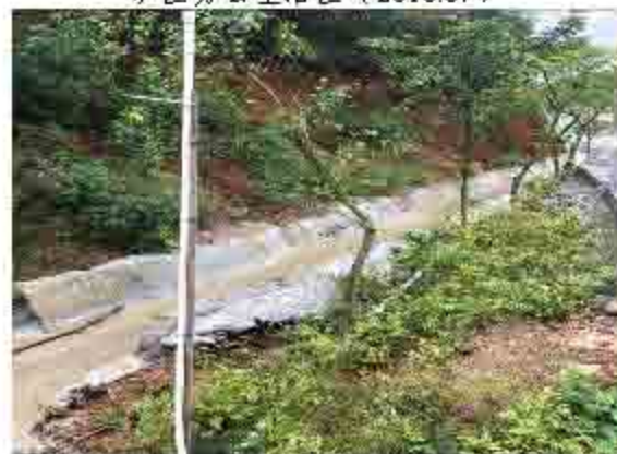
浆砌石排水沟 (2018.10)
