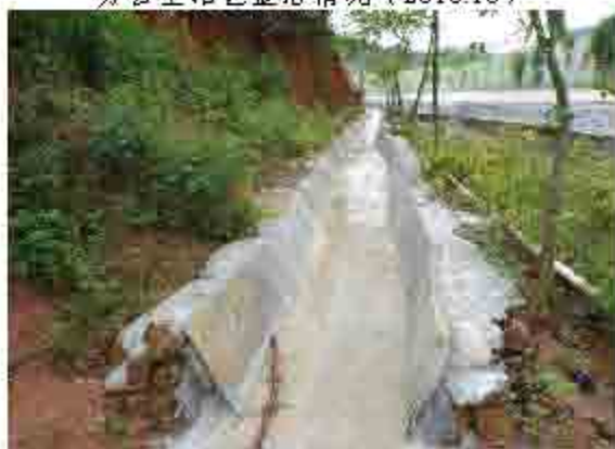
浆砌石排水沟 (2018.10)
