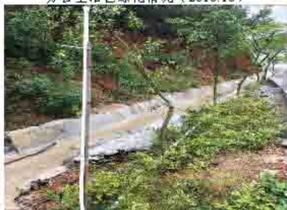
浆砌石排水沟 (2018.10)
